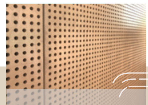
教室の窓下の壁
