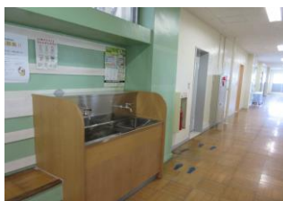
2～4Fの廊下に手洗い場増設。(レバー式)
