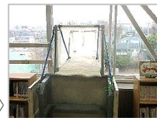
〈避難スロープ〉
