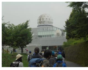
富士山レーダードーム
