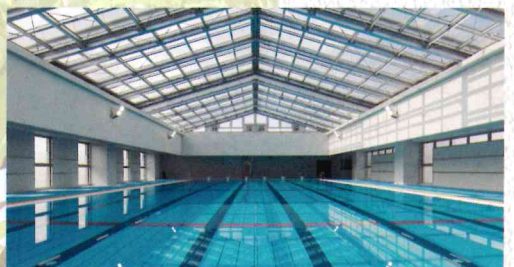
①屋上プール
