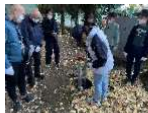
地下水道管から 水を取り出す訓練
