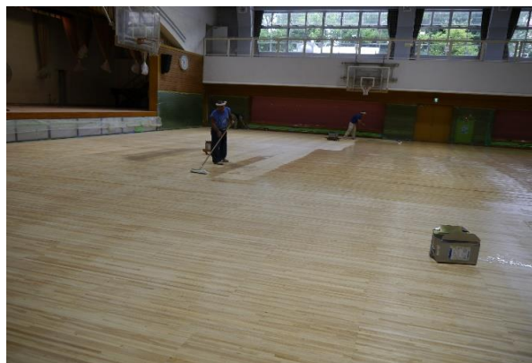
▲3回削った後に塗料を塗っているところ (8/20)
